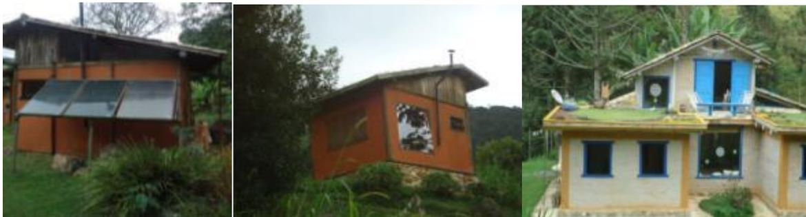
Figura 9 – O Tao das Artes. Da esquerda para a direita: Placas solares para aquecimento da água; Chaminé da lareira e Teto verde. Fonte: Ana Carolina Diório, 2016.
